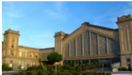
Façade nord de la Gare Maritime Transatlantique aujourd'hui Cité de la Mer
